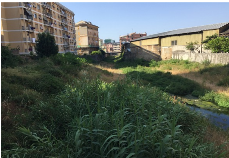
Fotografia 15 tratto 3, torrente Chiaravagna. Vista verso sud ripresa dal ponte di Via VIII Società Case. Si vede il ponte pedonale di Via Leonardi.
