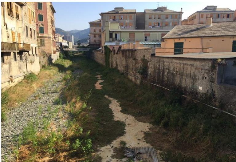
Fotografia 12 tratto 3, torrente Chiaravagna. Vista verso nord ripresa dal ponte di Via Chiaravagna. Si vede il ponte di via Giotto.
