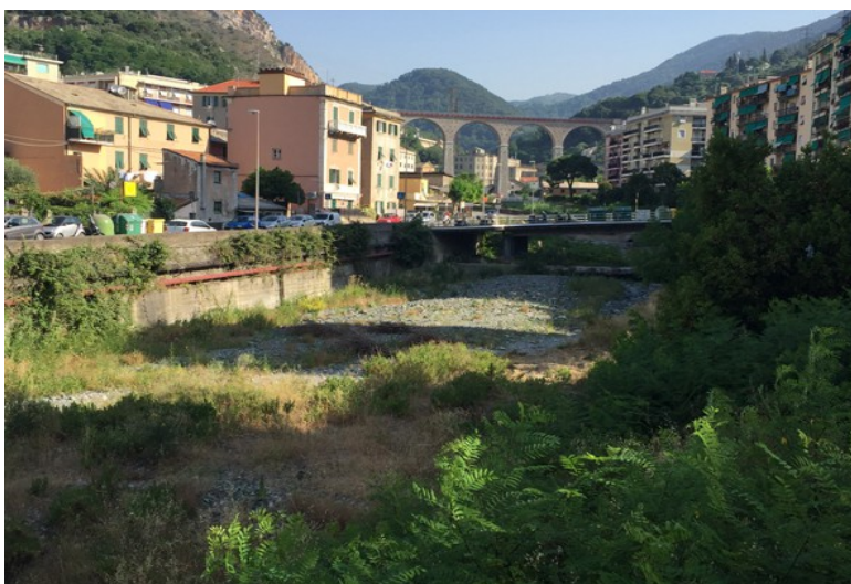
Fotografia 20, torrente Chiaravagna. Vista verso nord ripresa dal ponte di Salita al Santuario. Questa immagine è relativa ad un'area non interessata degli interventi a progetto.
