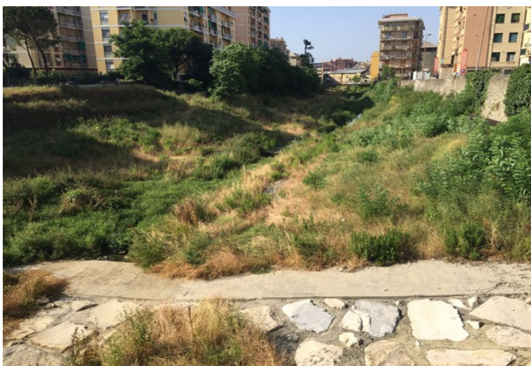
Fotografia 17, torrente Chiaravagna. Vista verso sud ripresa dal ponte Sergio De Simone. In quest'area sono già state realizzate delle briglie in alveo a valle e a monte del ponte.
