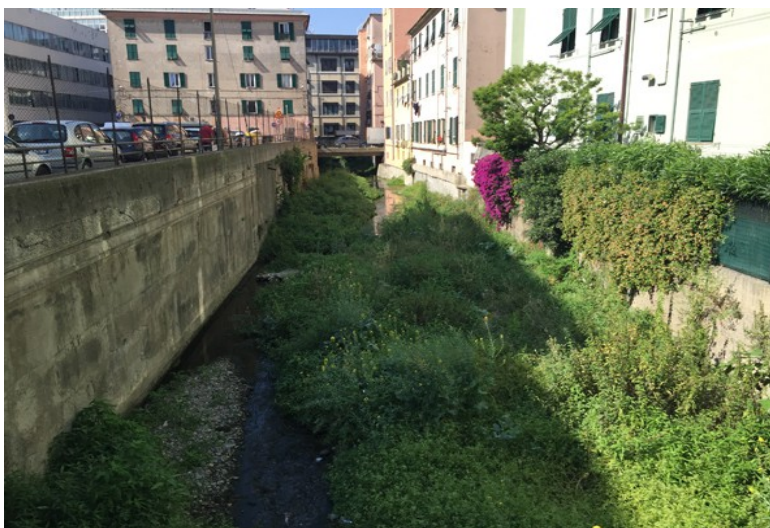
Fotografia 21, rio Ruscarolo. Vista verso sud ovest ripresa da via Borzoli. Si vede il rio a valle della sua tombinatura, all'altezza del Convento di San Nicola (sito S8). Questa immagine è relativa ad un'area non interessata degli interventi a progetto.
