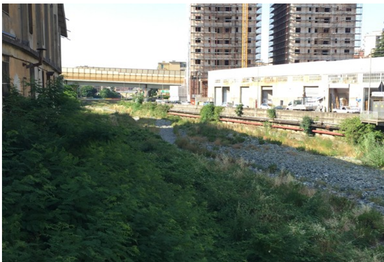
Fotografia 19, tratto 3 bis, torrente Chiaravagna. Vista verso sud ripresa dal ponte di Salita al Santuario. Si vede il viadotto Chiaravagna.
