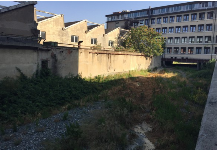
Fotografia 04: tratto 1, torrente Chiaravagna. Vista verso nord ovest ripresa dal piazzale compreso tra il corso d'acqua e l'edificio ABB. Sull'argine destro si affaccia un edificio industriale otto/novecentesco mentre poco più a monte si trova un edificio contemporaneo a ponte sul torrente.
