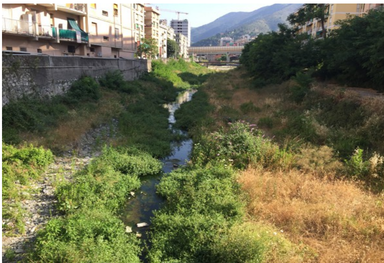
Fotografia 16 tratto 3, torrente Chiaravagna. Vista verso nord ripresa dal ponte di Via VIII Società Case.
