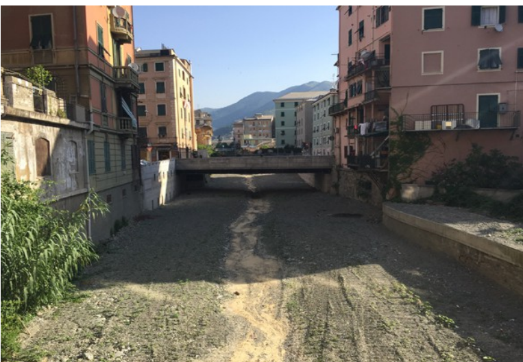
Fotografia 06: tratto 2, torrente Chiaravagna. Vista verso nord ripresa da Via Manara. Si vede il ponte di Via Giotto.
