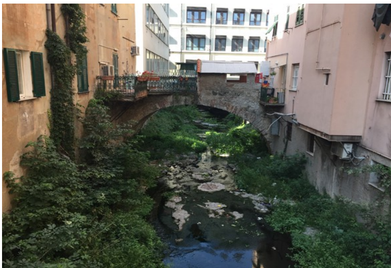
Fotografia 22, tratto 2, torrente Chiaravagna. Vista verso sud ovest ripresa da via Giotto. Si vede il ponticello ad arco in pietra (presumibilmente sito I1).
